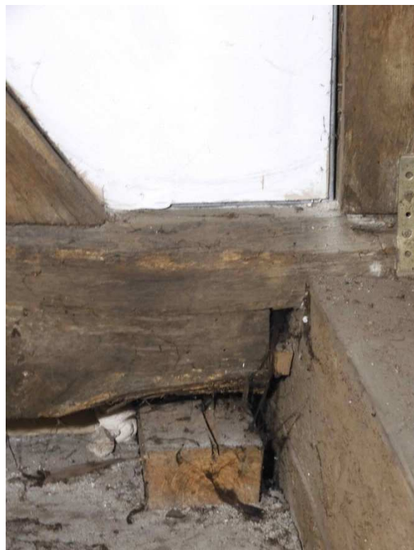
Fot. 12 Oparcie ściany poprzecznej wewnętrznej na podwalinie
