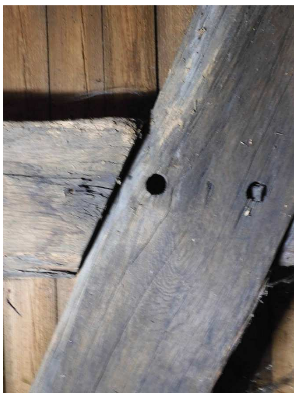
Fot. 15 Rozluźnione węzły, brakujące kołkowanie
