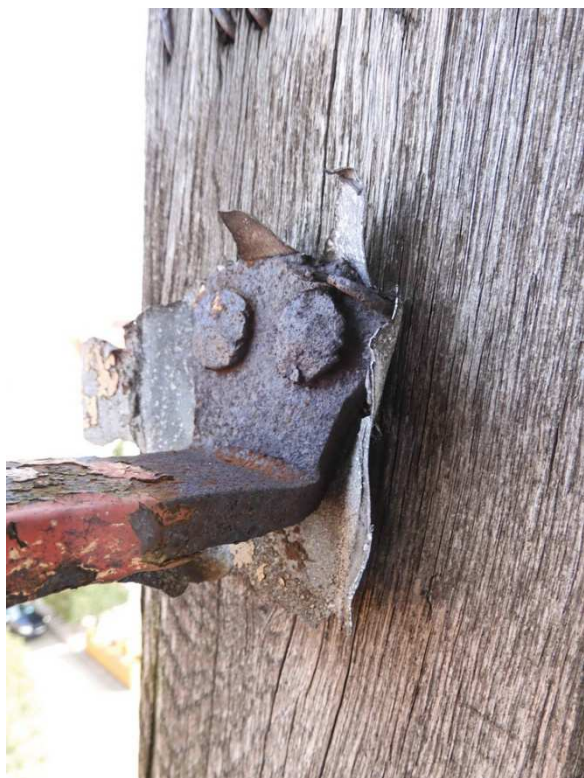
Fot. 9 Mocowanie balustrady tarasu
