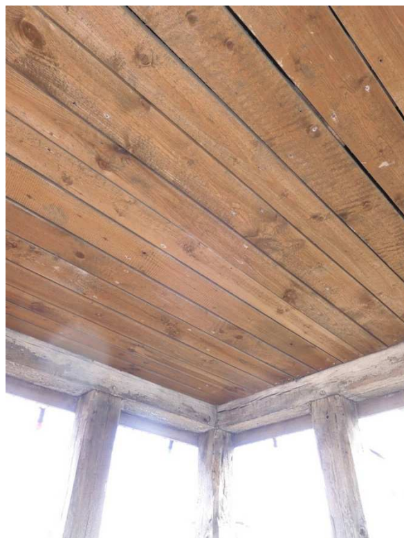
Fot. 10 Deskowanie podniebienia hełmu wieży
